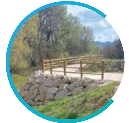
L'épi du Parc après les travaux de mise en sécurité
