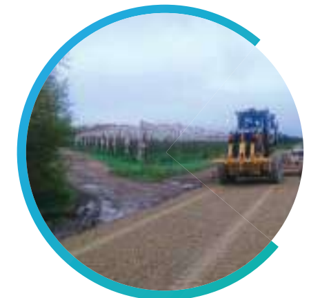
Travaux de création de la véloroute vers Sénas
