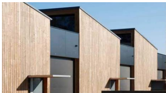
Locaux d'activités et espaces de stockage Village des Métiers - Avignon
