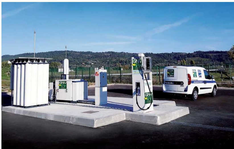
Figure 129 : Station GNV d'Apt (source : https://www.gaz-mobilite.fr/actus/premiere-station-gnv-intercommunale-vacluse-2150.html )
