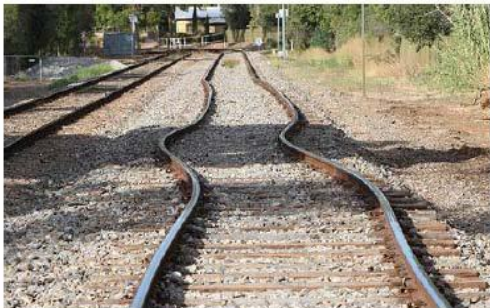
Figure 99: Déformation des rails du RER D lors de la canicule de 2003.
